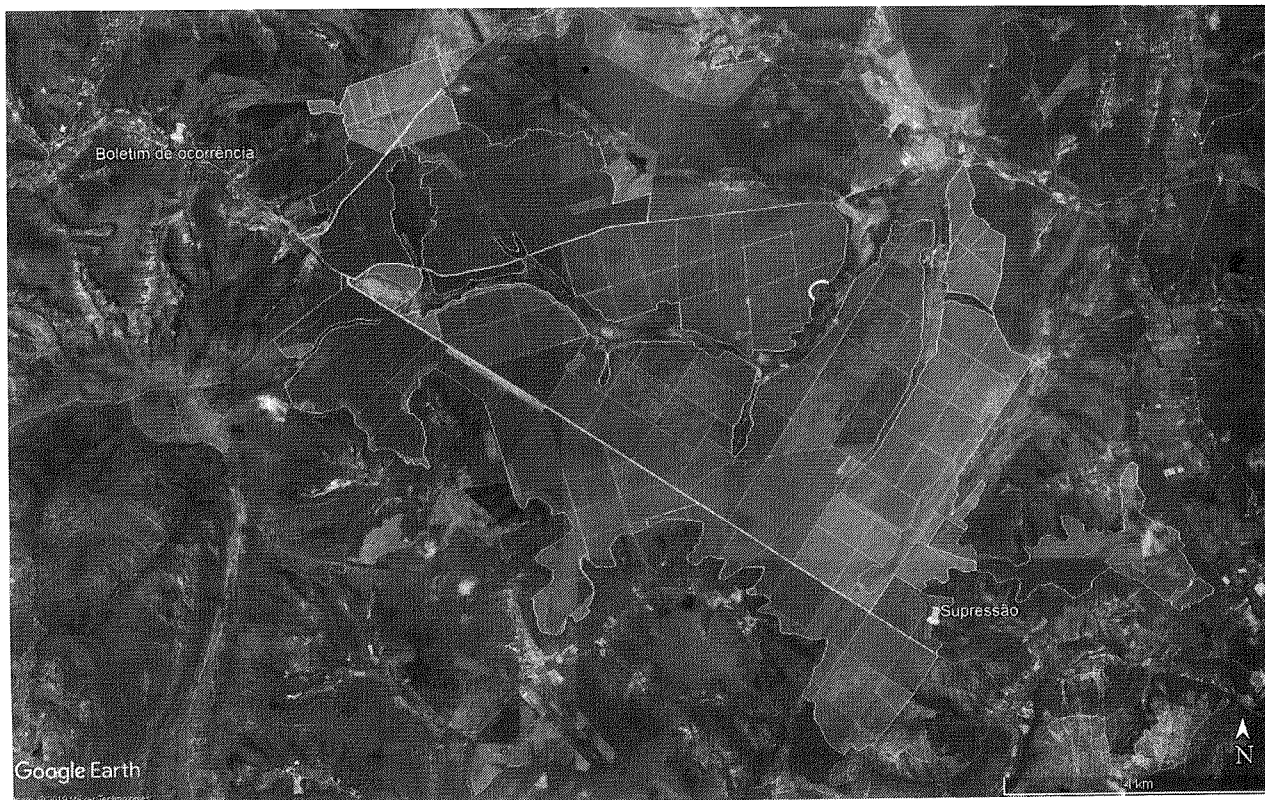
Imagem 07 – Visão geral da fazenda Vale das Embaúbas e distância entre a coordenada da supressão verificada em vistoria e a coordenada especificada no boletim de ocorrência número M7104-2018-00001232 de 05/09/2018 fornecido pelo empreendedor (13 km).
