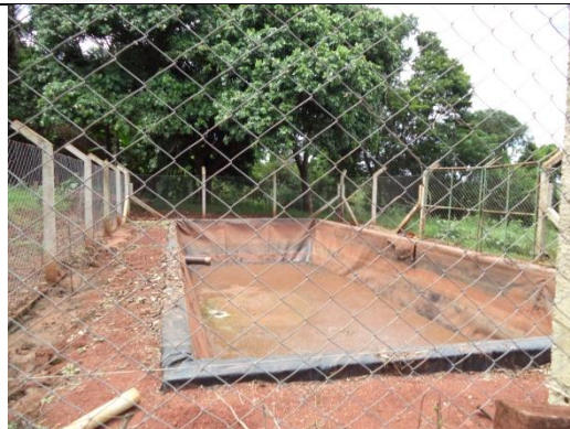
Figura 02. Lagoa de tratamento
