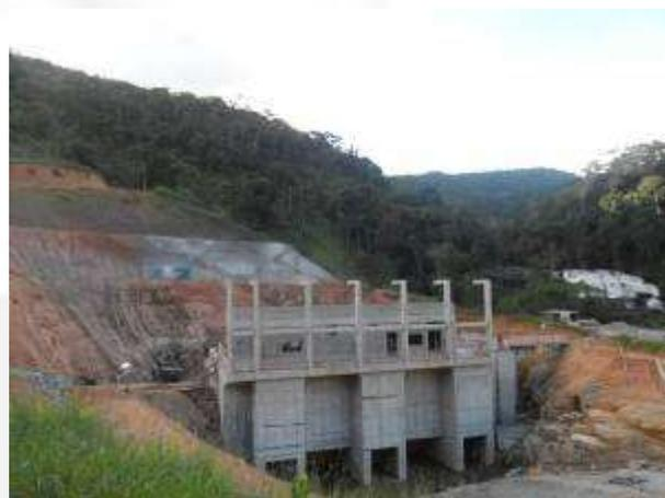
**Foto 04.** Vista geral das obras da Casa de Força e Túnel de adução.
