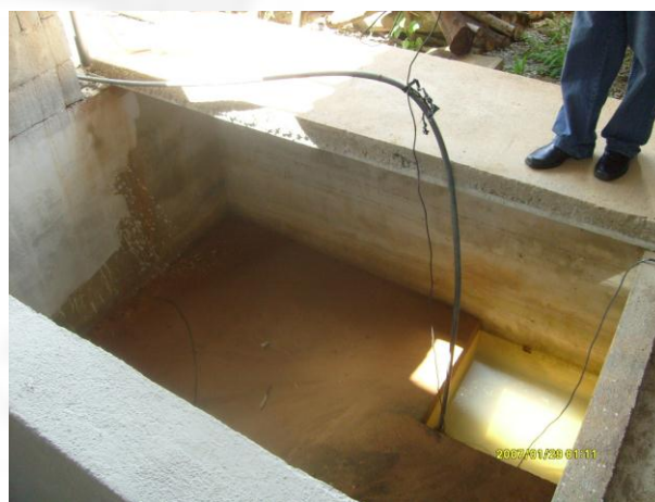
Foto 06. Tanque equalizador
