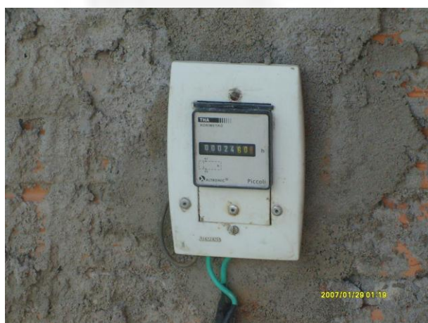
Foto 03. Horímetro instalado
