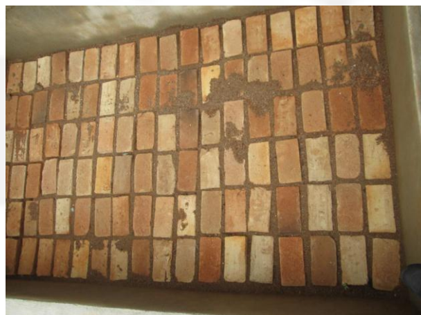
Foto 08. Leito de secagem concluído
