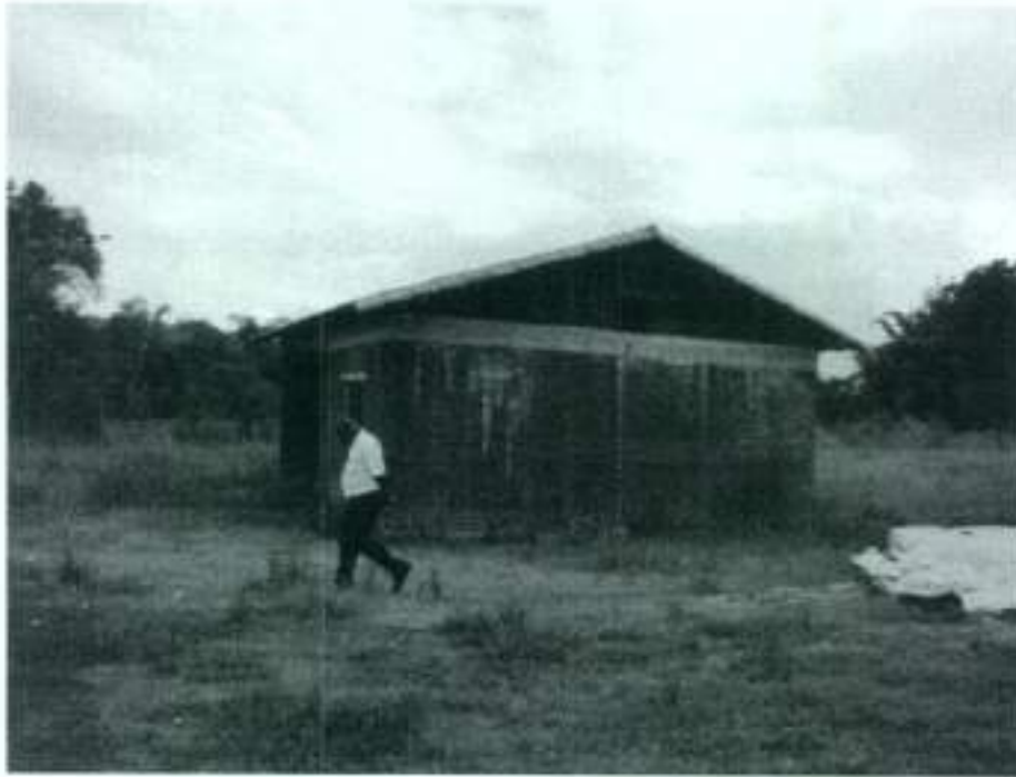
Figura 13 – Casa construída com rejeito de tratamento de minério de ferro
