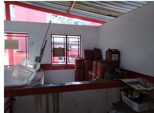
Foto 04: Depósito temporário de resíduos (interior)
