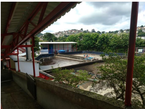
Foto 05: Estação de Tratamento de Efluentes Líquidos
