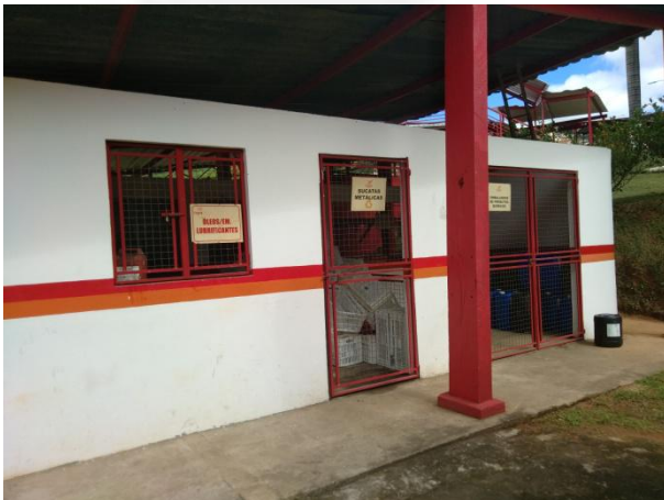
Foto 03: Depósito temporário de resíduos (exterior)
