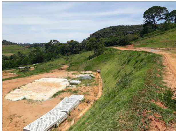
Foto 08. Revegetação de talude
