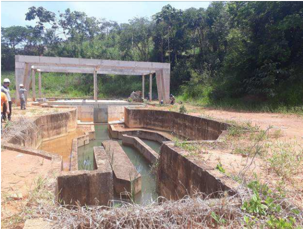
Foto 01. Elevatória em obras
