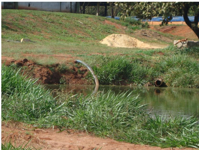
Foto 03: vista da 2ª lagoa de decantação. Detalhe de falta de impermeabilização
