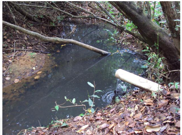
Foto 04. Ponto de lançamento do efluente sanitário tratado.
