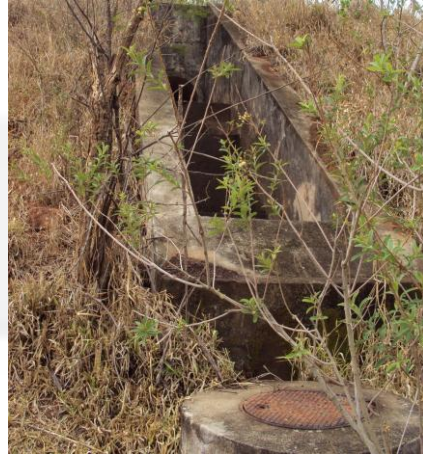
Foto 02. Estruturas do sistema de drenagem pluvial
