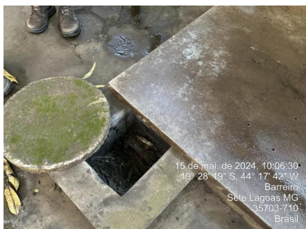
Foto 25: Saída da CSAO, completamente seca, com presença de folhas.
