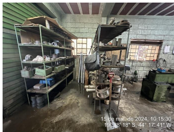
Foto 28: Sala de apoio associada à oficina.
