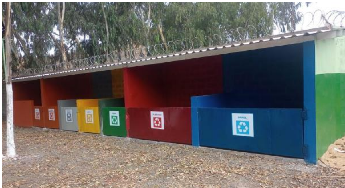
Figura 40. Baias de Resíduos na Siderúrgica Setegusa Ltda
