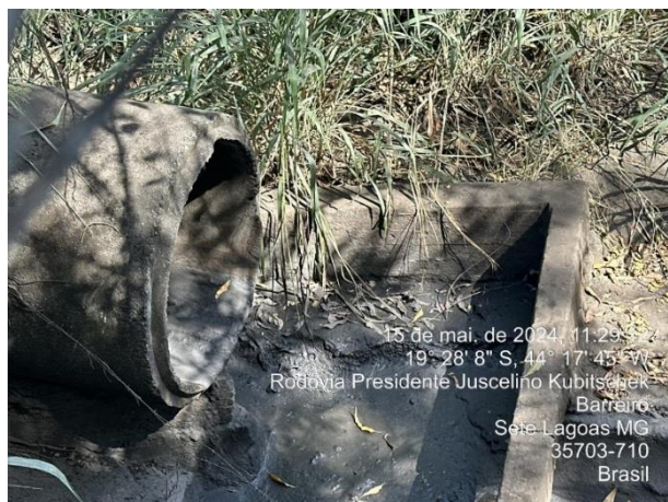
Foto 11: Ponto de lançamento dos efluentes pluviais e da CSAO, na área da empresa vizinha, com significativa quantidade de sedimentos e pó de balão.
