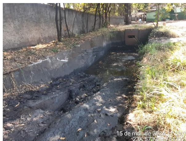
Foto 10: Bacia de contenção de sedimentos localizada no final do sistema de drenagem (coordenadas UTM 23K 573905 / 7847128).
