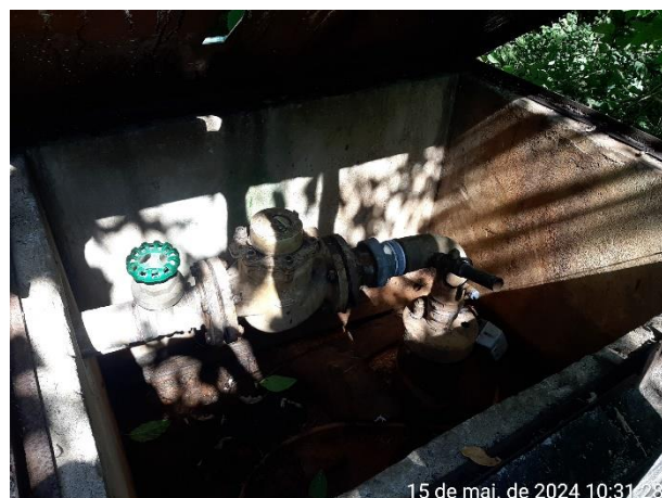
Foto 40: Detalhe interno da caixa na saída do Poço 02. Verifica-se o tubo de monitoramento, torneira e hidrômetro.
