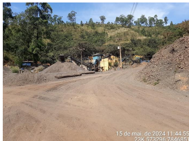
Foto 14: Planta de britagem de escoria.
