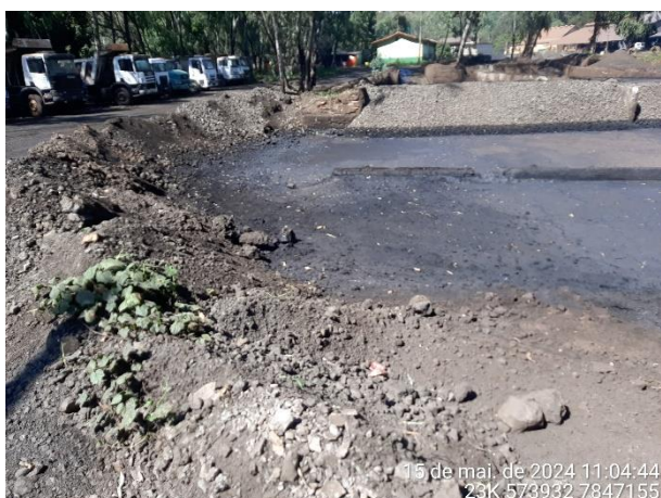
Foto 17: Leira de material implantada para contenção do pó de balão em decantação.
