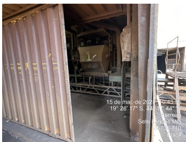
Foto 55: Parte da área de recebimento de minério.
