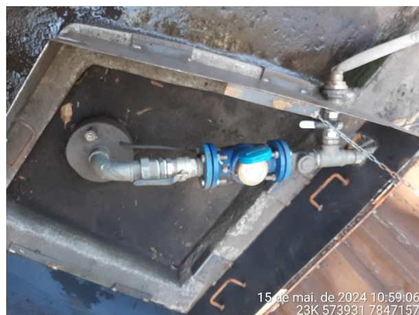
Foto 42: Caixa de alvenaria com tampa de aço do Poço artesiano 03, localizado na área operacional da empresa.
