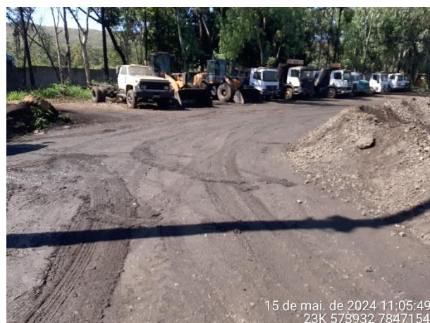
Foto 18: Acesso à área de operação localizado a jusante das baías de decantação, coberto com material semelhante ao pó de balão, caracterizando indícios de extravasamento de pó de balão.
