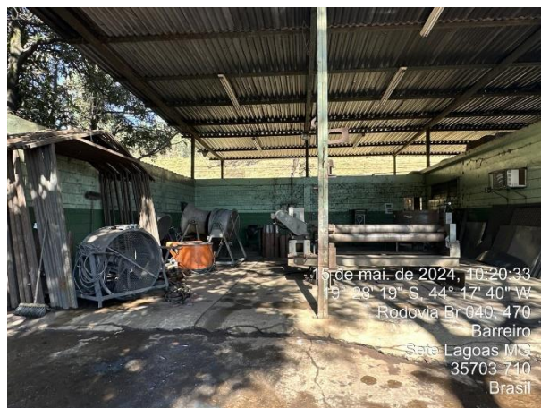
Foto 32: Galpão anexo da oficina.
