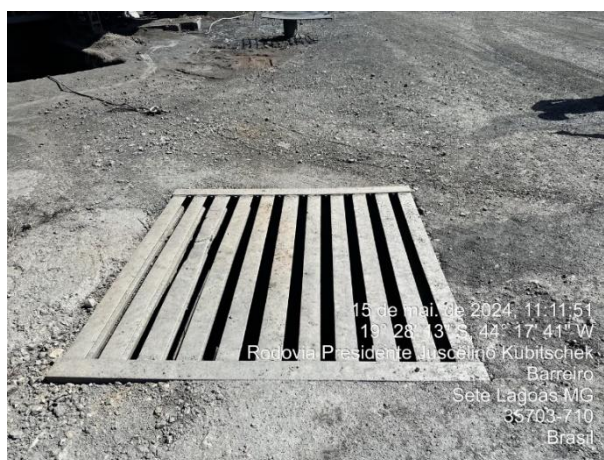
Foto 62: Caixa de passagem de efluentes de água pluvial.
