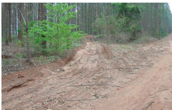
Foto 11. Bacia de retenção adjacente à estrada vicinal no interior da propriedade, Ponto E02
