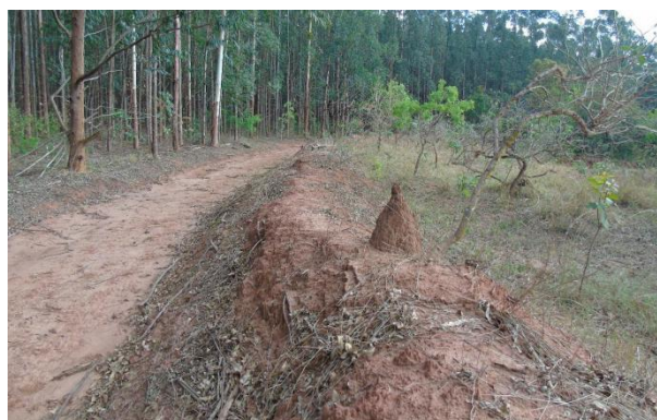
Foto 12. Barreira física de contenção da água superficial situado no entorno do processo erosivo, Ponto E6
