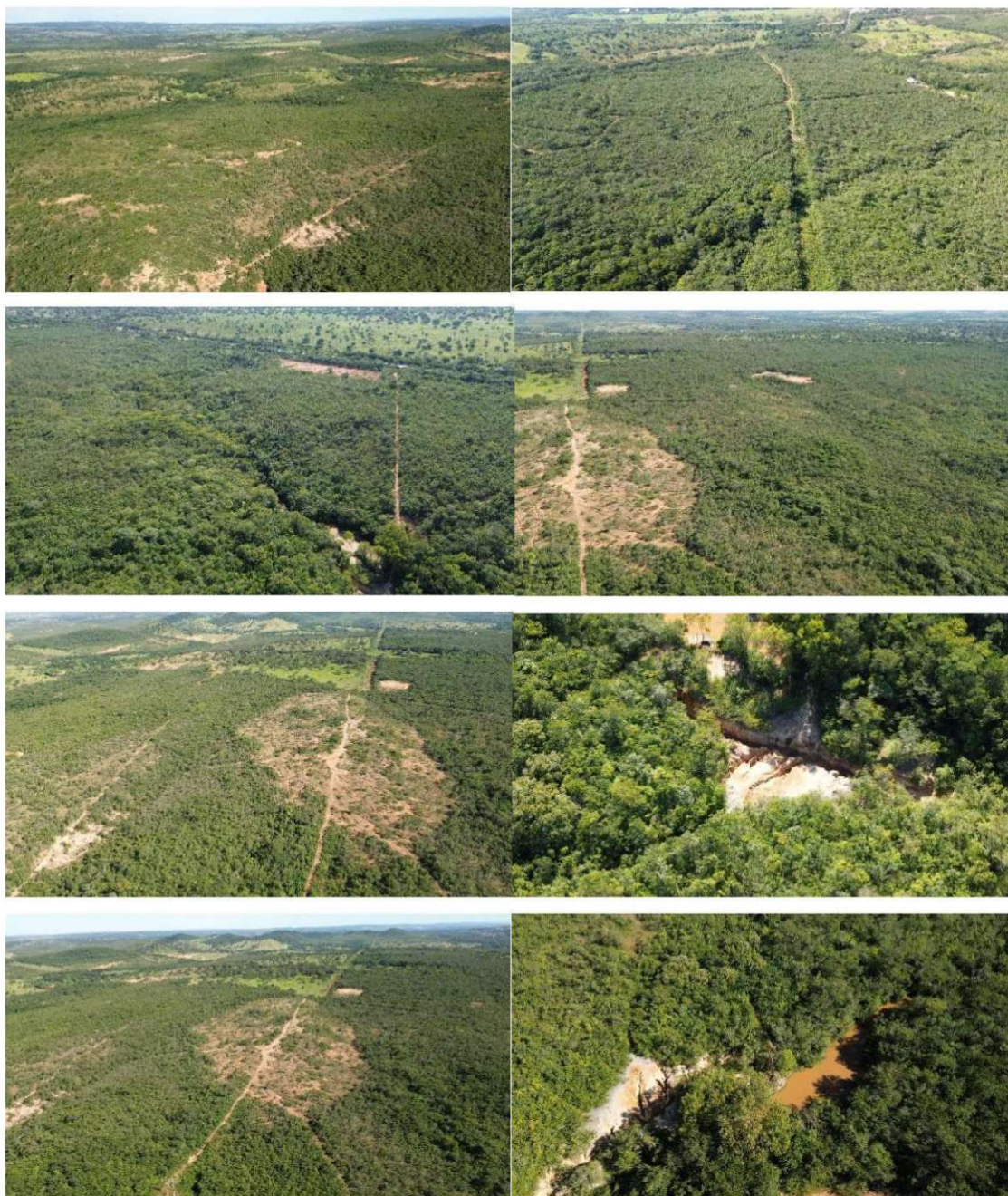
Figura 2. Mosaico de imagens com vistas aéreas da área do estudo identificando a vegetação nativa cobrindo toda a ADA bem como detalhe de uma linha de transmissão com apresentação de área de drenagem pluvial com formação de barramento.
