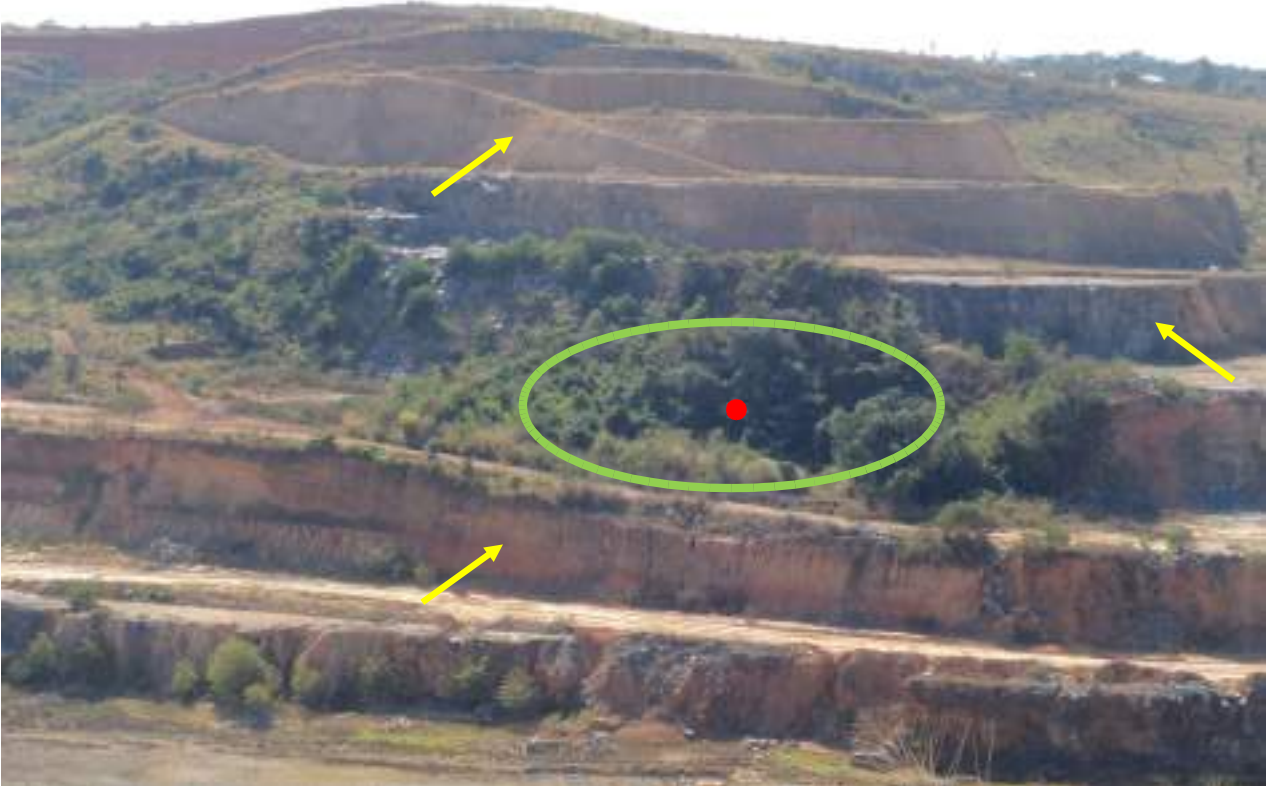
Figura 6. Inserção da LIZ-0010 (ponto vermelho), bancadas de argila e local desmonte de rocha (setas amarelas), remanescente florestal (marcação verde).
