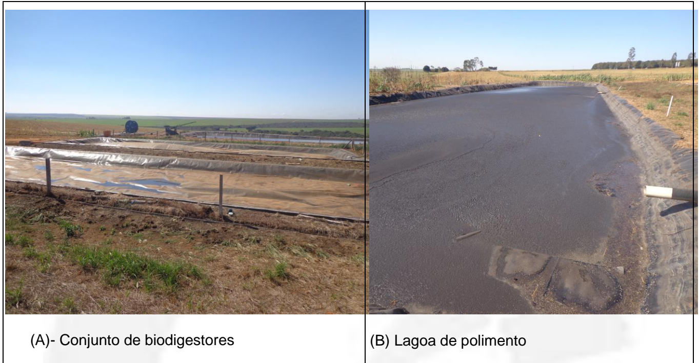
Figura 01 – Sistema de tratamento de efluentes da suinocultura
