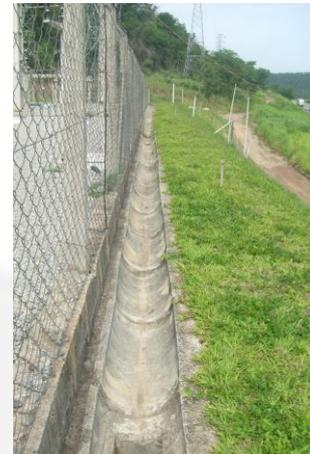
**Foto 06.** Canaleta para águas pluviais
