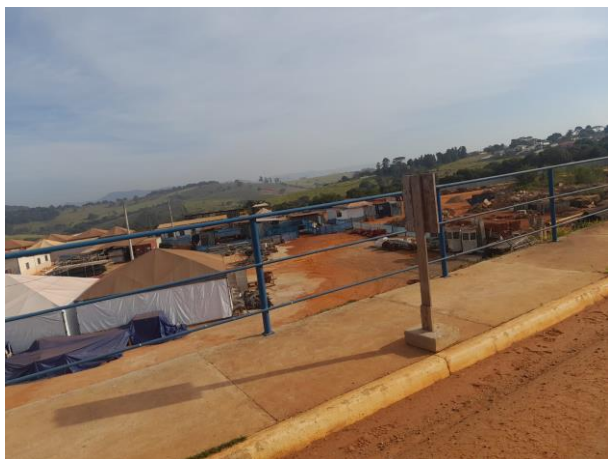
Foto 1: Canteiro de obras, visto de cima
