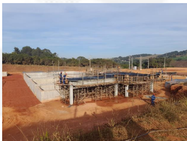
Foto 12: ETEI em instalação
