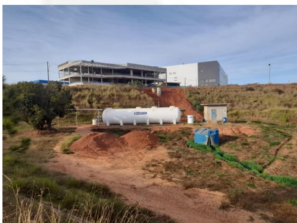
Foto 11: ETE sanitária em uso
