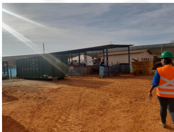
Foto 4: Depósito temporário de resíduos
