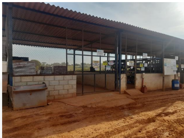
Foto 8: Depósito de produtos químicos da obra
