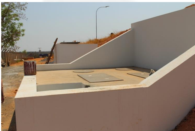
Foto 15 e 16 – caixas separadoras de água e óleo
