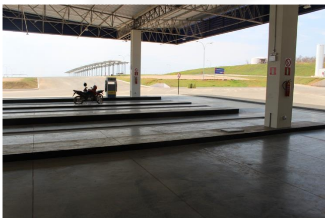
Foto 19 e 20 – área coberta para troca de óleo, com piso concretado com canaletas ligadas ao SSAO, e dois tanques aéreos de capacidade de armazenamento de 10 m 3 cada de óleo para motor; sendo que os tanques aéreos estão dentro de uma bacia de contenção de concreto e com canaletas ligadas ao SSAO;
