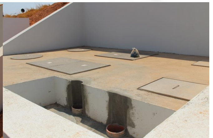
Foto 15 e 16 – caixas separadoras de água e óleo
