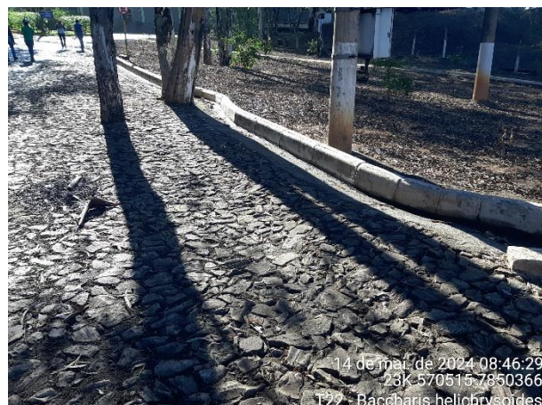
Foto 30: Canaleta coletora de água de parte dos acessos na área operacional.
