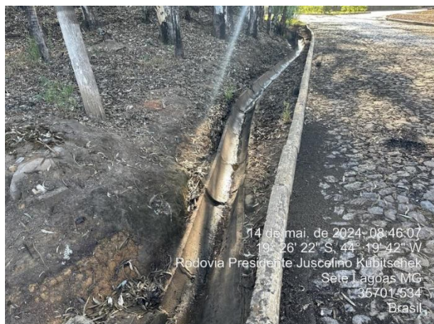
Foto 29: Canaleta que recolhe e direciona água proveniente da parte mais alta do empreendimento.,
