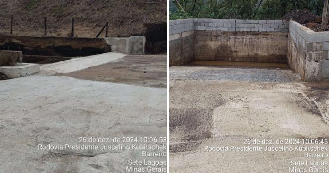
Figura 17. Muro de contenção muro de contenção lateral e uma caixa de decantação de concreto, com função emergencial de recolhimento das águas pluviais que possam carrear pó de balão.
