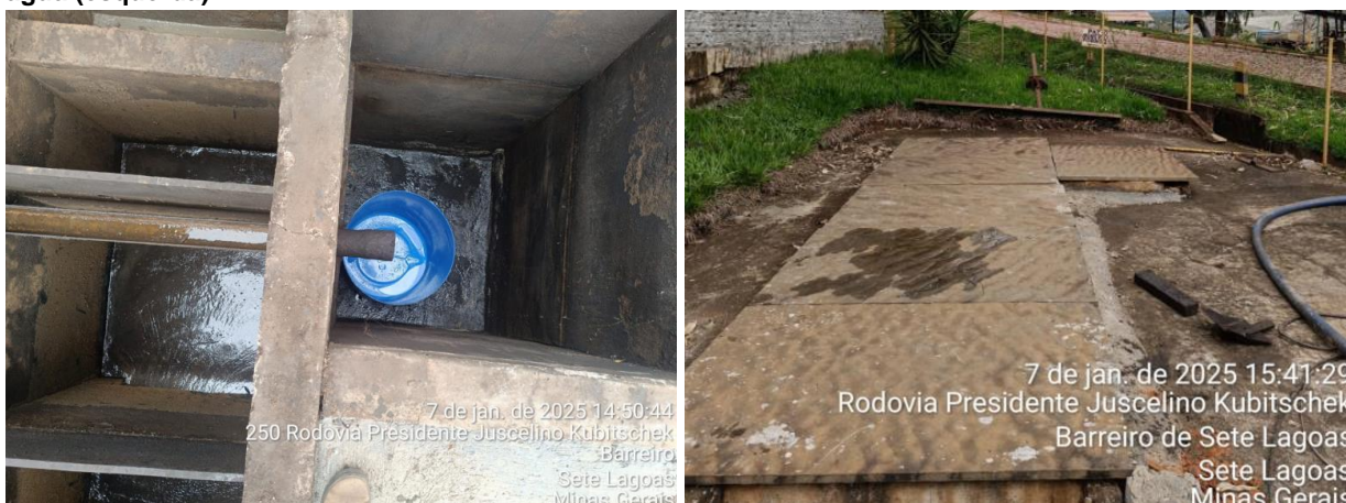
Figura 19. A caixa cega foi drenada e equipada com um tubo conectando à calha, direcionando o óleo para um balde /tambor para destinação adequada (Direita). As tampas foram ajustadas para impedir a entrada de água (esquerda).
