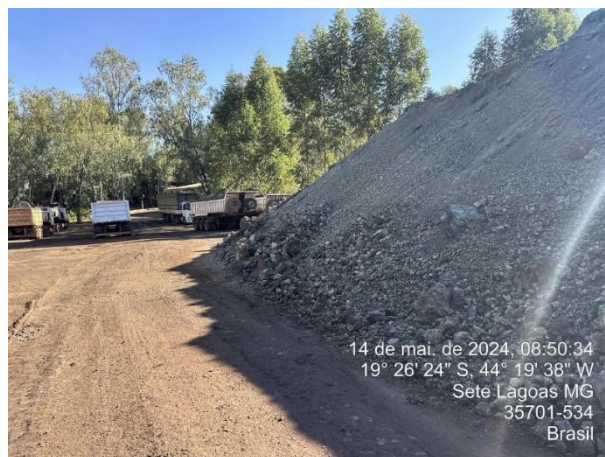
Foto 22: Evidência da pilha invadindo parte do acesso da área operacional.
