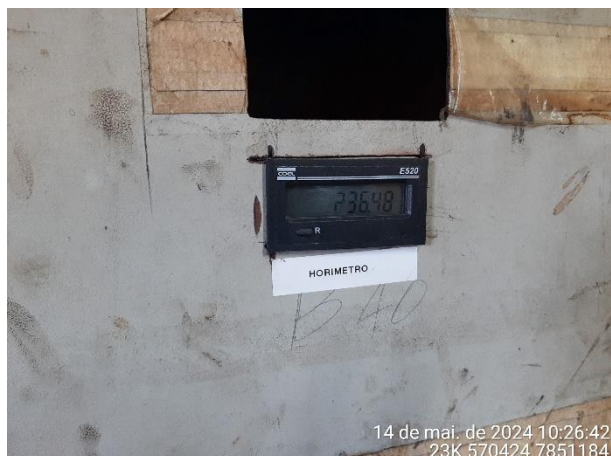
Foto 35: Horímetro na casa de bombas.
