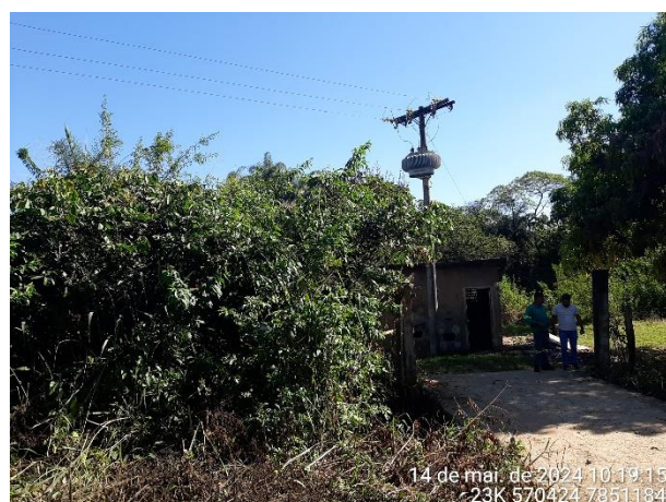
Foto 38: Chegada da linha de transmissão elétrica na casa de bombas.
