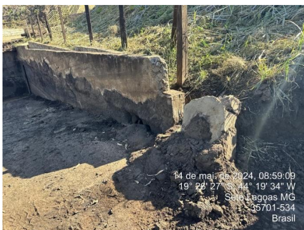
Foto 13: Avaria observado no tanque de decantação.
