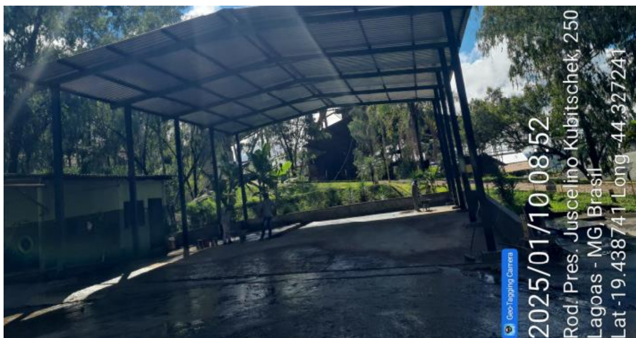
Figura 4. Área de lavagem ocorrerá em área coberta com telhado de estrutura metálica.
