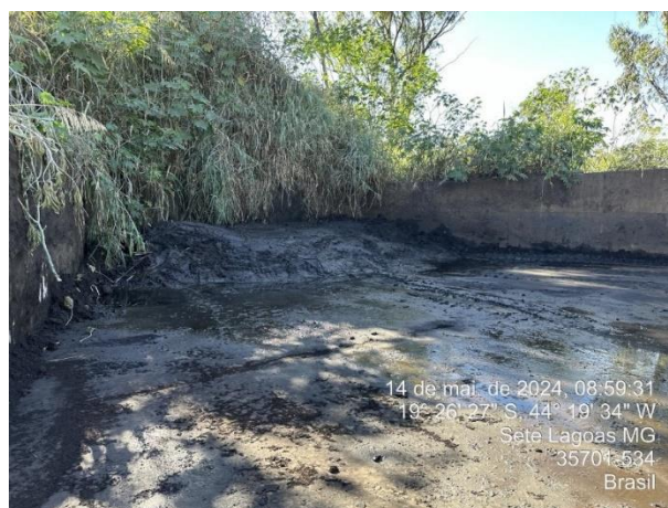
Foto 14: Material que está fora dos tanques de decantação, que foram raspados para a margem da área. Este material está contido por muro de concreto.
