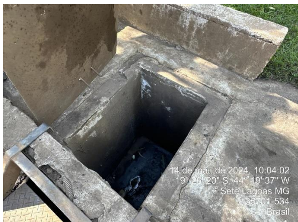
Foto 5: CSAO que recebe efluentes do posto de combustível, oficina e lavador de veículos. Vista da entrada da CSAO.
