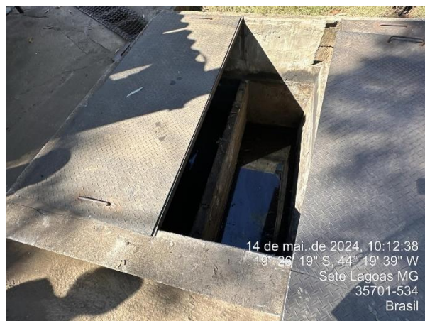
Foto 6: CSAO que recebe efluentes do posto de combustível, oficina e lavador de veículos
