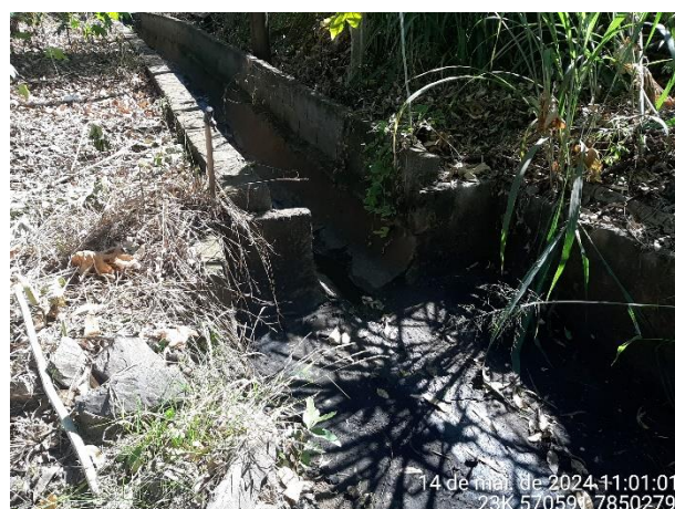
Foto 32: Vertedouro do tanque final de decantação de águas pluviais.
