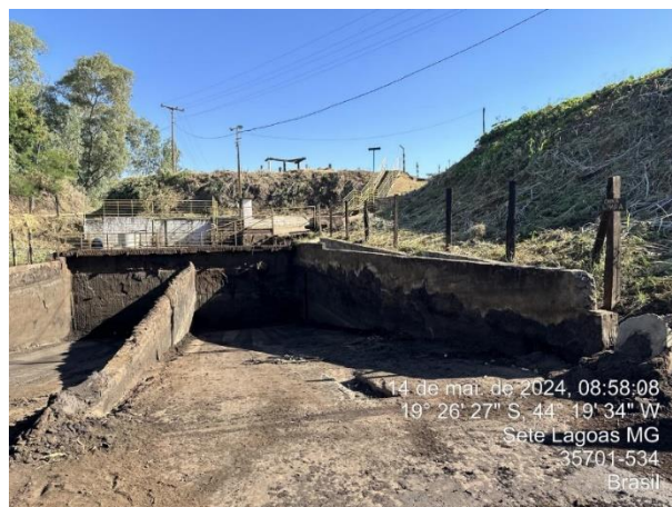
Foto 12: Tanque de decantação de pó de balão, com indícios de retirada recente de material.
