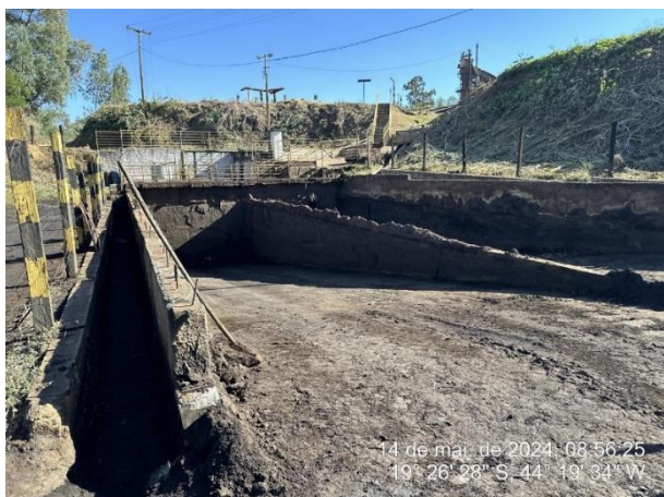
Foto 11: Tanque de decantação de pó de balão.
