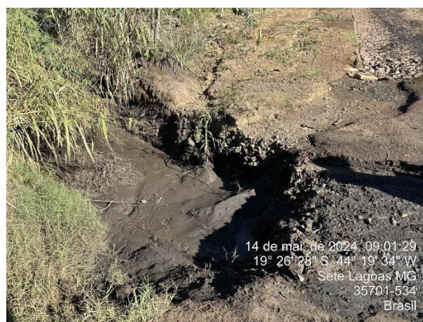
Foto 26: Cacimba existente coletora de água de chuva com sedimento de pó de balão.
