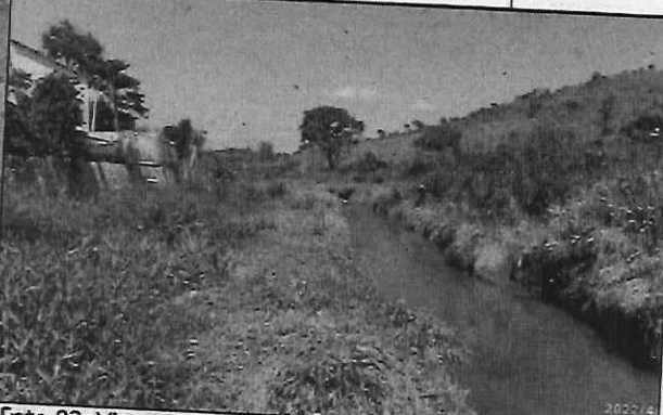
Foto 02: Vista do canal novo (à direita) e do local do antigo canal (a esquerda - vegetação verde próximo ao muro).
