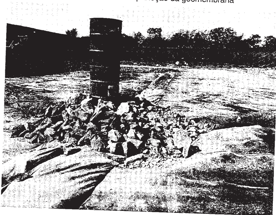
Drenos e início da cobertura
