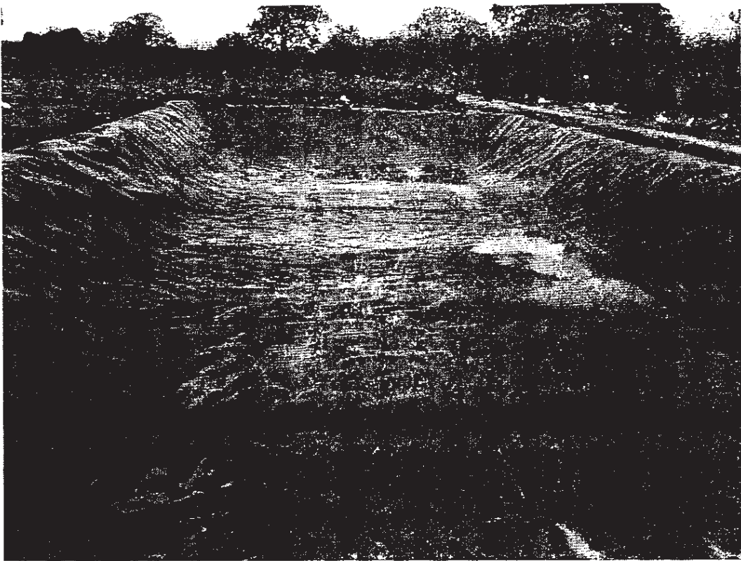
Lagoa de acumulação do percolado
