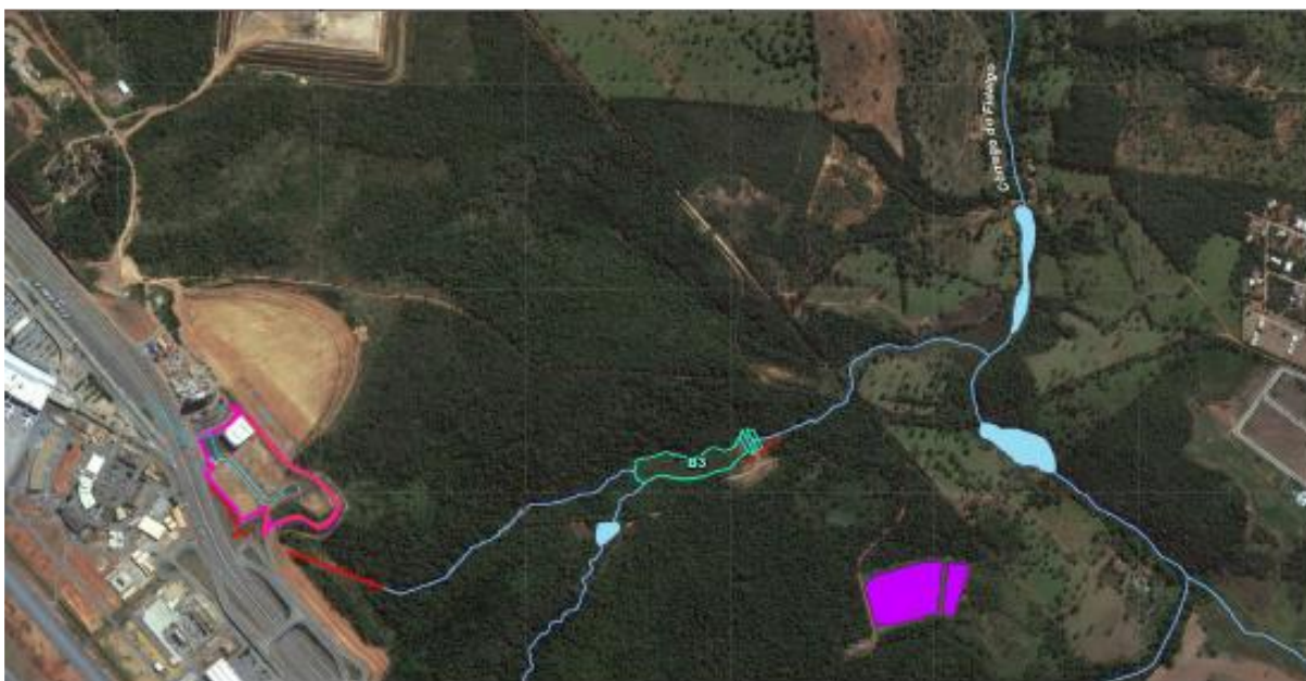
Figura 03 – Construção da Barragem B3
