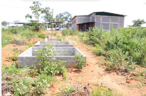
Figura 9: Tratamento de efluentes sanitários.
