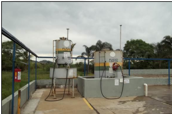
Foto 03. Ponto de abastecimento.
