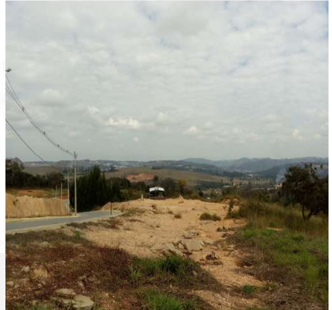
Imagem 15: Vista da Quadra 03 e talude com solo exposto
