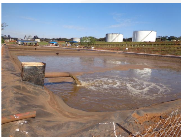
Tanques de Águas Residuárias impermeabilizados com Geomembrana.
