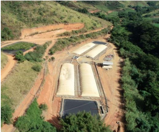
Foto 05 e 06: alguns dos biodigestores e algumas baterias de lagoas da Fazenda São Joaquim.
