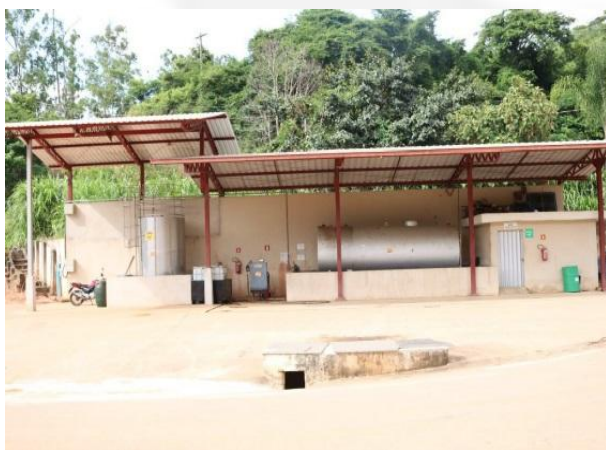
Foto 15 e 16: posto de abastecimento com bacia de contenção e caixa separadora de água e óleo.
