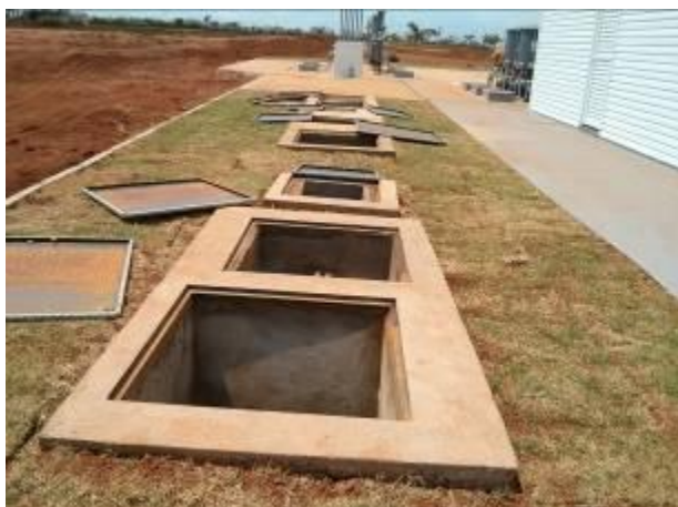
Foto 05: Sistema de separação de água e óleo
