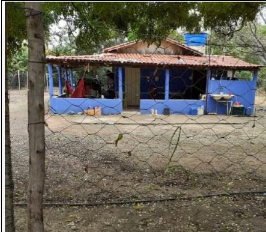
Foto 03. Vista da infraestrutura do empreendimento – casa sede.
