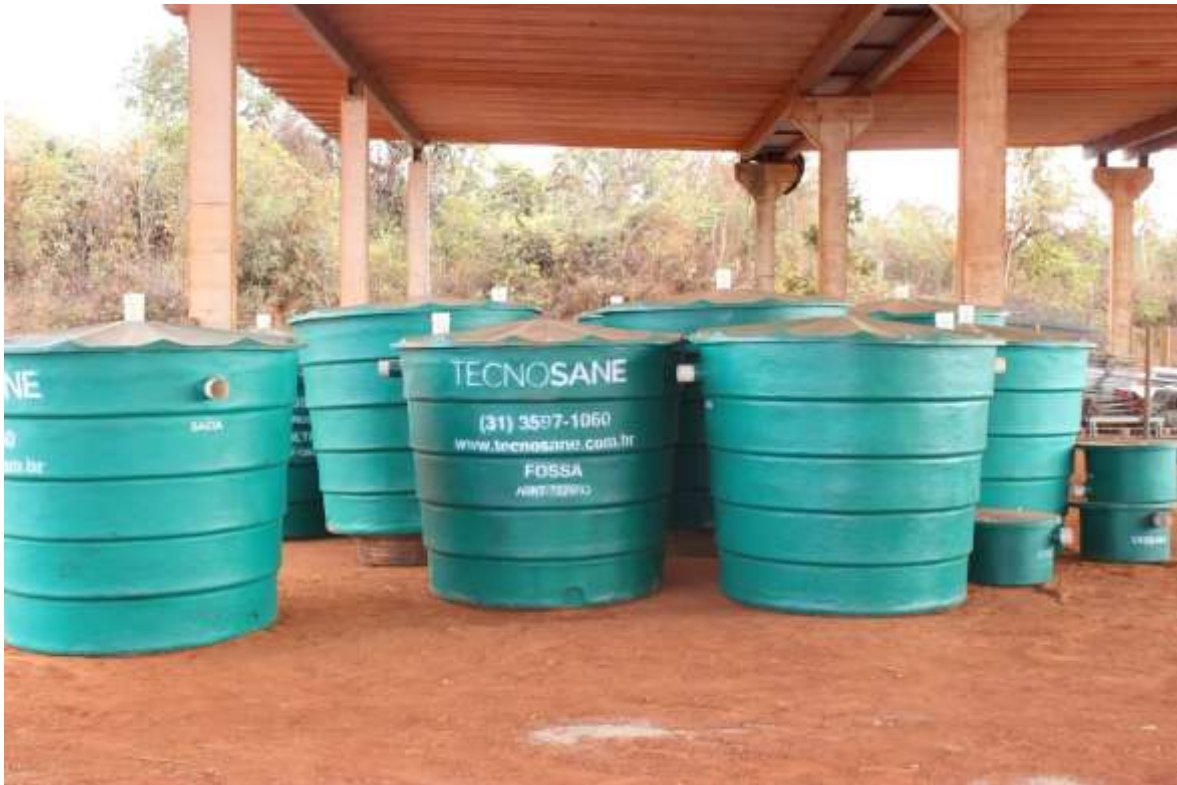
Unidades de tratamento de efluentes sanitários pré fabricadas armazenadas na área do empreendimento.
