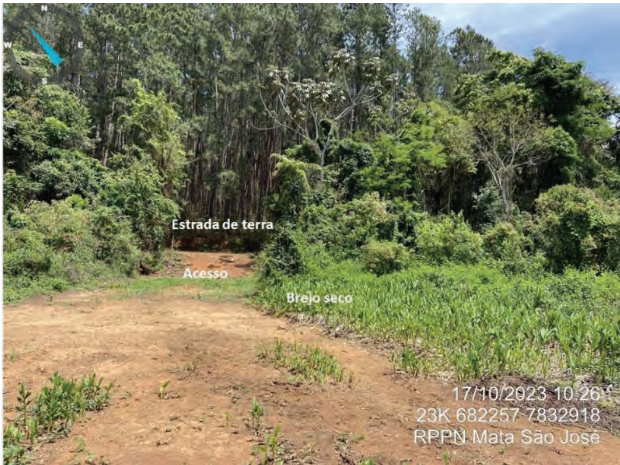
Foto 4-61 Abertura de acesso a partir da estrada para área de brejo. Nota-se brejo seco.
