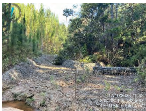
Foto 4-44 Estrutura de drenagem com arrimo em gabião.
