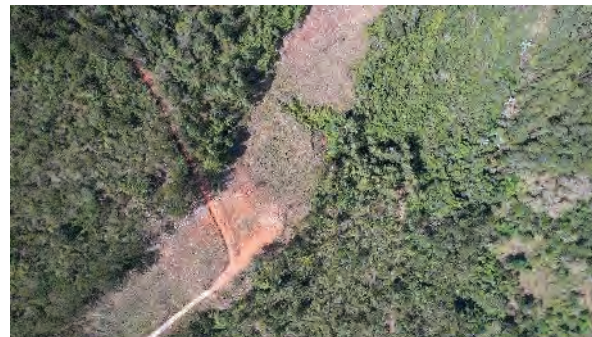
Foto 4-27 Linha de transmissão de energia elétrica com estrada não pavimentada e solo exposto na faixa de servidão com início de processo erosivo
