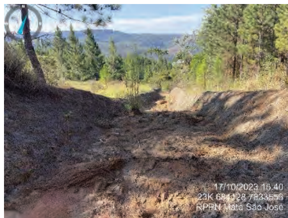
Foto 4-42 Vala de drenagem.
