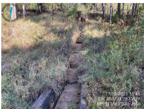
Foto 4-43 Escada hidráulica na porção norte da unidade.
