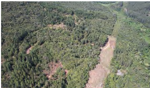
Foto 4-26 Linha de transmissão de energia elétrica com parte da faixa de servidão composta por campo antrópico e parte com regeneração de floresta
