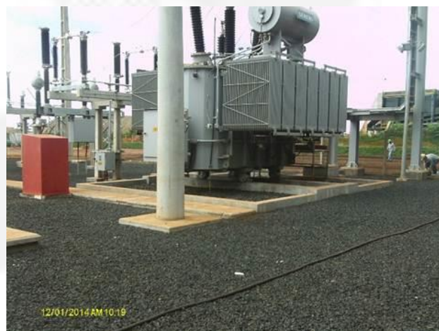
Transformador com caixa de contenção.
