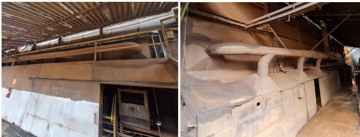
Figura 22. Coifas e captações de poeira de minério Forno 01 (Direita). Coifas e captações de poeira de minério Forno 02 (Esquerda).
