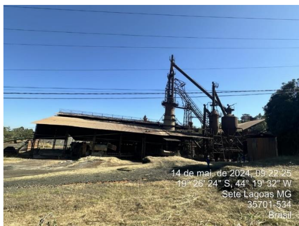
Foto 61: Vista geral da área fabril.
