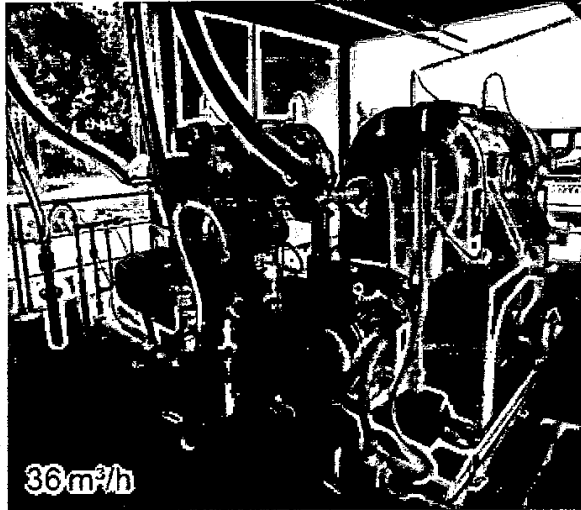
Desidratação do Lodo dos Reatores
