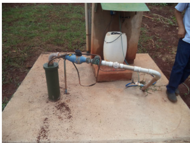
Foto 15 e 16. Poço tubular com Hidrômetro e horímetro
