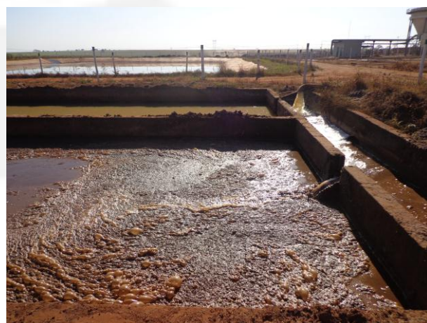
Foto 22. Tanque de decantação de água residuária
