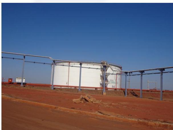
Foto 07. Tanque de armazenamento de etanol
