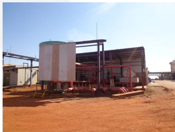
Foto 16. Sistema de combate a incêndio
