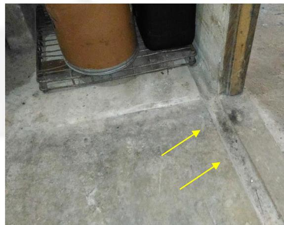
FOTO 6 – Depósito de resíduos com canaleta de drenagem.
