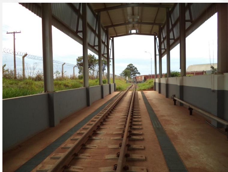
Foto vistoria: Vista da área de acessos das locomotivas
