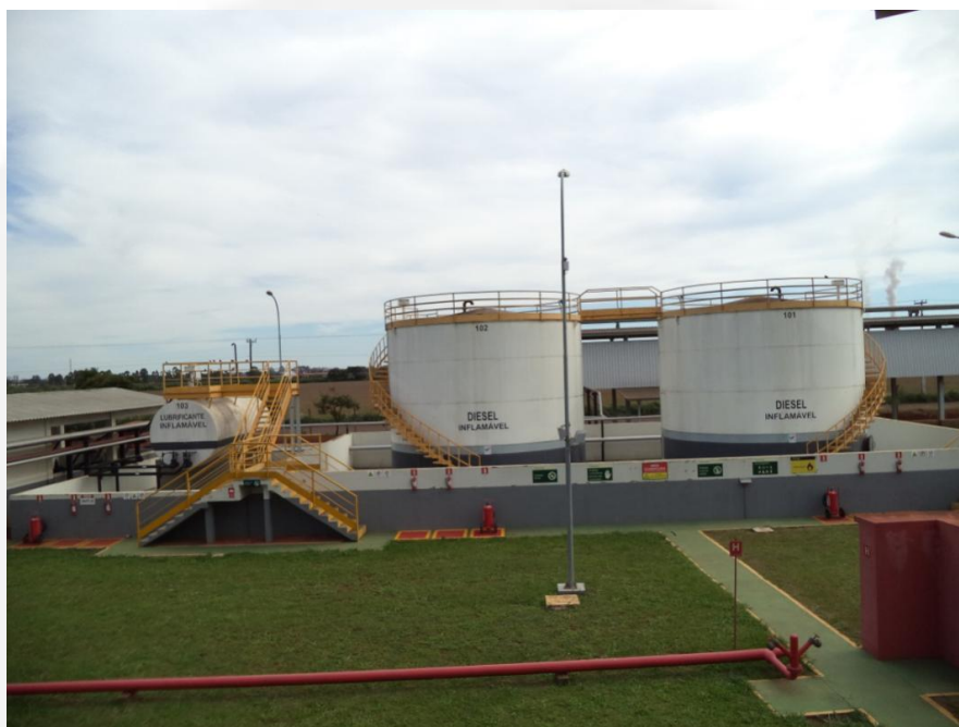
Foto vistoria: Vista dos Tanques
