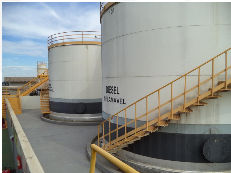
Foto vistoria: área dos tanques com bacia de contenção
