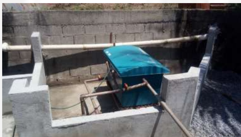
Foto 03. Nova caixa Separadora de Água e Óleo - SAO instalada para receber efluente da oficina mecânica e lavador de peças.
