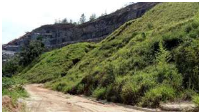
Foto 02. Pilha de disposição de estéril com canaleta de escoamento de águas pluviais e talude vegetado. Ao fundo a frente de lavra.
