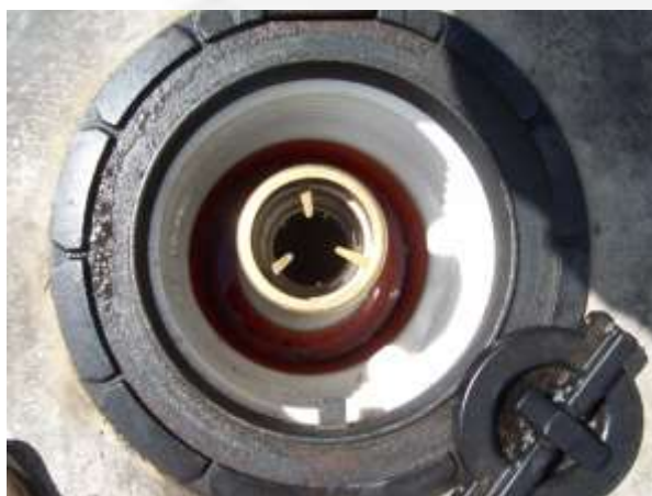
Foto 01. Câmara de contenção de descarga de combustível
