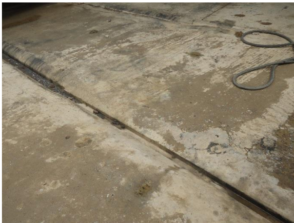
Foto 03. Canaleta da oficina
