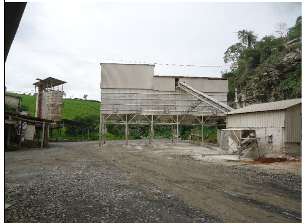
Foto 08. Silo da cal
