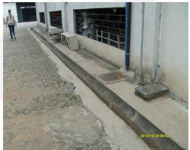
Foto 4: Drenagem pluvial
