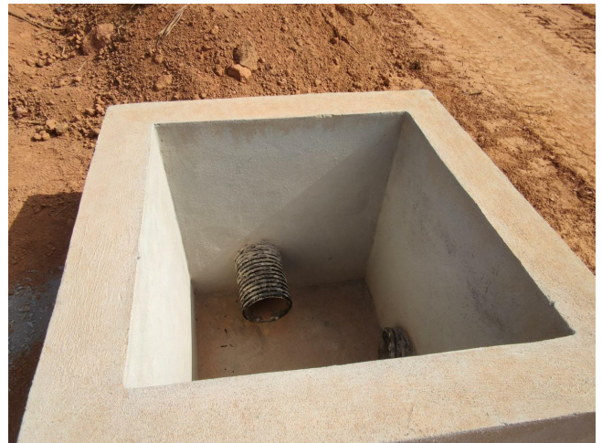
Interior das caixas de inspeção (líquido percolado)
