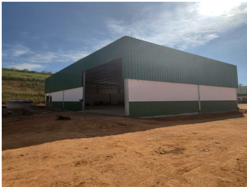
Galpão de quarentena de veículos e/ou resíduos
