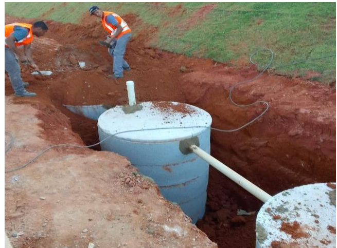
Implantação do sistema fossa séptica/filtro anaeróbio
