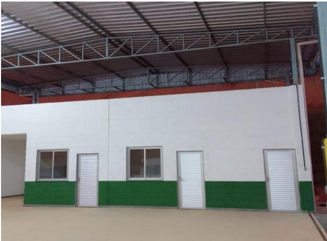
Galpão de manutenção
