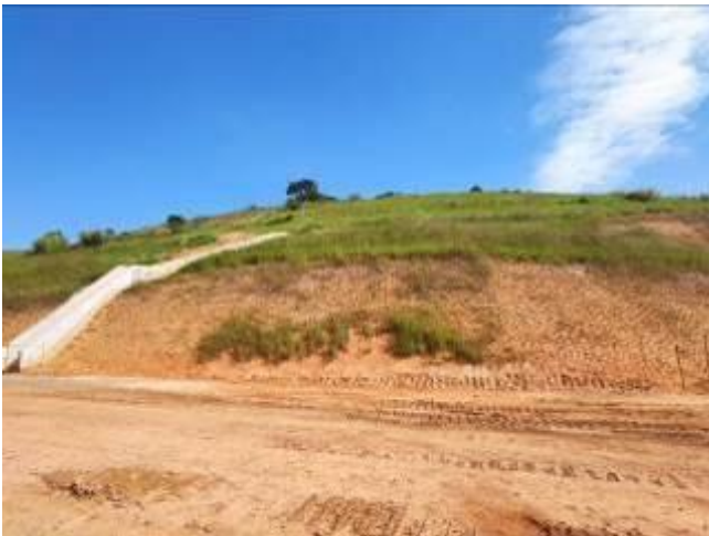
Escada hidráulica e revegetação de taludes
