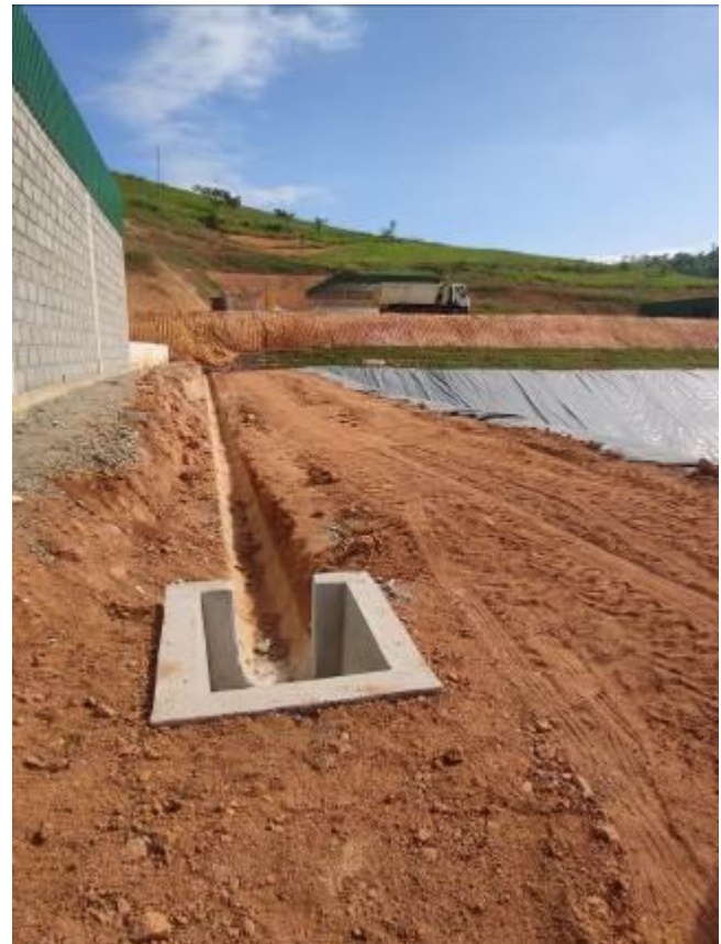
Drenagem pluvial área da ETE (aos fundos revegetação de talude)
