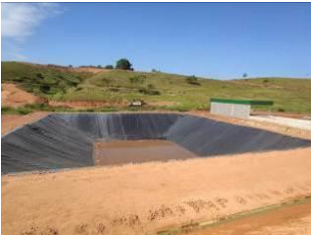
Edifício de apoio da ETE e Lagoa Anaeróbia
