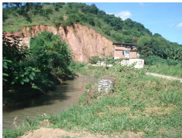
Foto 04. Trecho para retificação do curso d'água. Um antigo desvio causou a erosão ao fundo.
