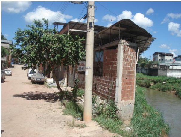
Foto 01. Ocupações irregulares na APP do Ribeirão.
