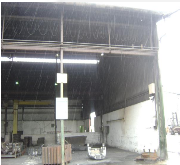
Foto 1: Vista do galpão nº 02.
