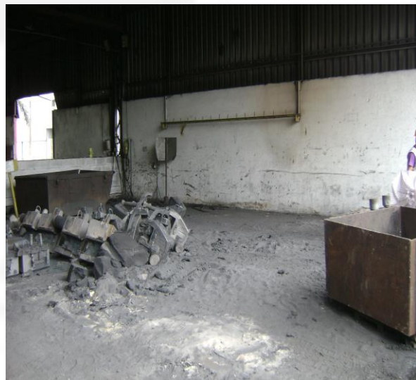
Foto 2: Local onde será instalado o forno rotativo.
