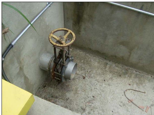
Foto 01. Emissário de lançamento do efluente tratado no curso d'água.
