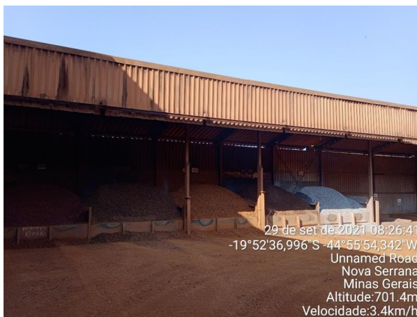
Foto 02: Silos de minério de ferro e fundentes.
