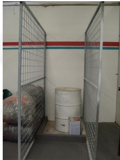
Foto 8: Depósito de resíduos sólidos – área com bacia de contenção.
