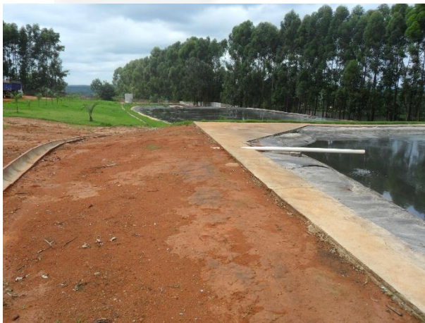
Foto 03. Estação de Tratamento de Efluentes Industriais.
