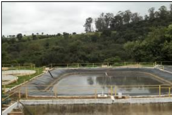
Foto 03. Lagoa da ETE.
