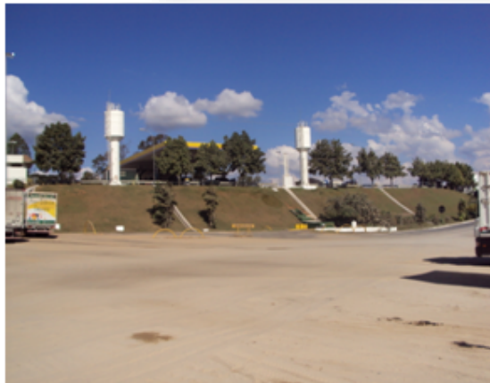
Foto 01. Vista geral do posto
