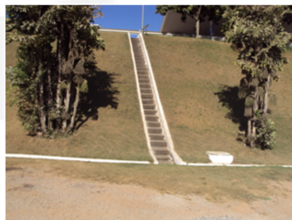
Foto 04. Escada dissipadora de energia
